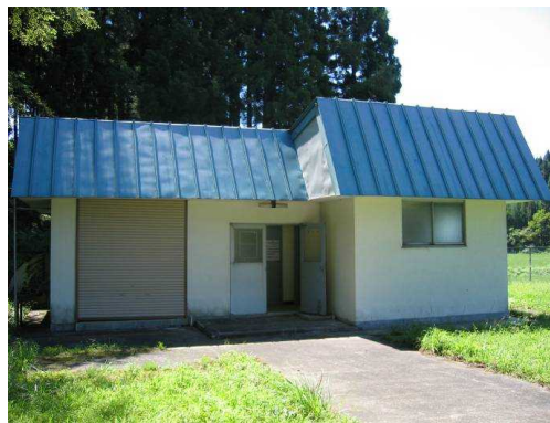
図 2-1-3 荒屋・上川目浄水場
