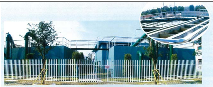
写真 1 和平鎮浄水場の外観
