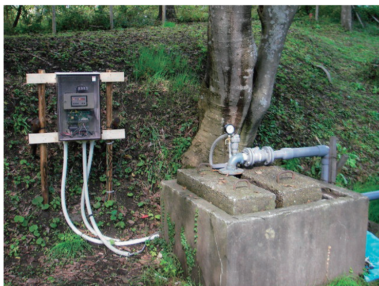
写真 5.7 刈羽第一水源取水ポンプ設置状況
