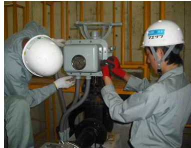
バルブの点検調査
