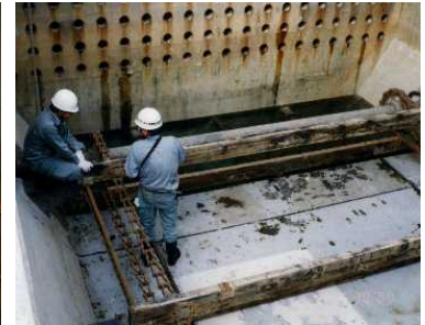
沈澱池機械の点検調査
