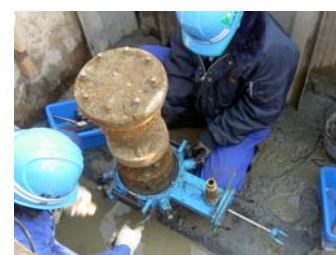
補修弁取替工法
