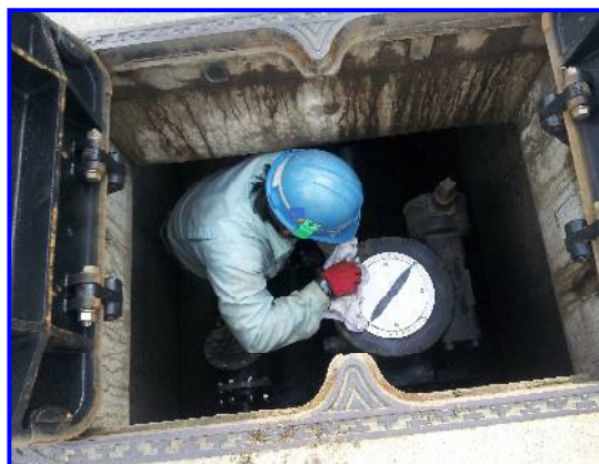
付属物調査(弁栓類点検)
