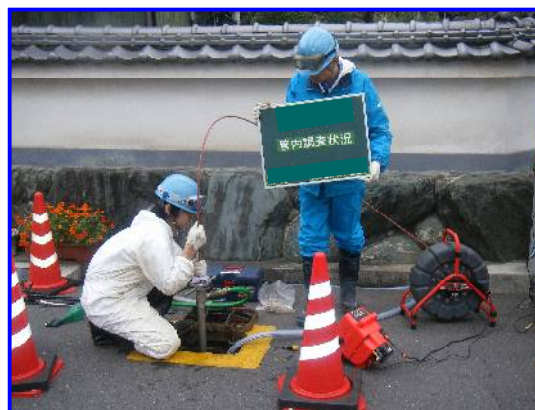
管内調査(不断水管内カメラ調査)
