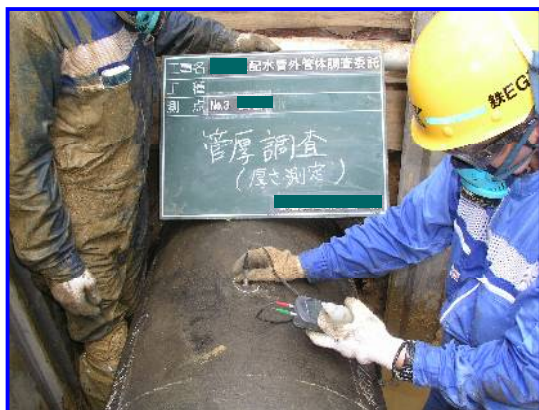
管体調査(超音波管厚測定)
