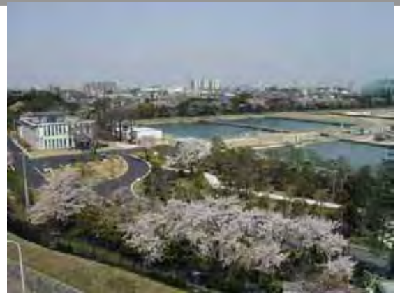
写真：日本で最も大きい緩速ろ過方式 浄水場（東京都 境浄水場） 処理水量：315,000m 3 /日
