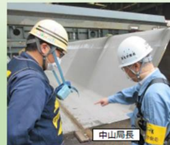
作業概況の点検を行う様子
