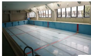
建築物解体撤去工事 内装解体、躯体、基礎の解体撤去 大型設備の残置物撤去
