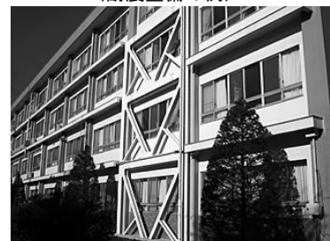
(耐震整備の例)
