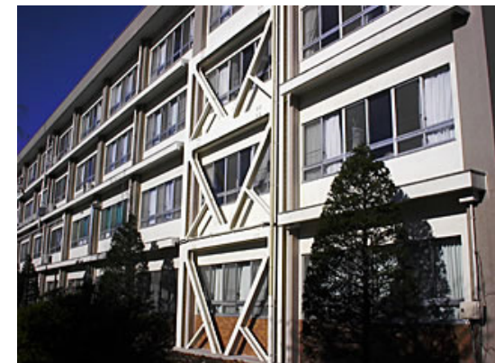
(耐震整備の例)
