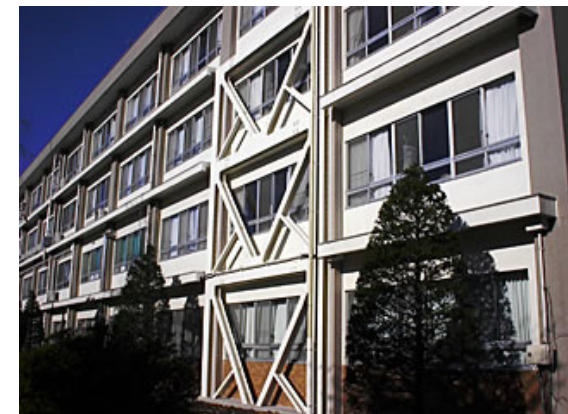
(耐震整備の例)
