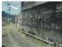
①ブロック塀改修工事施工前
