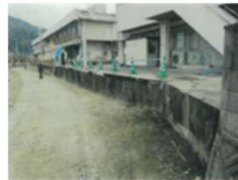
③ブロック塀撤去後
