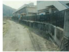
④ブロック塀改修工事施工後
