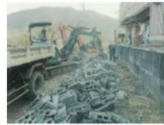
②ブロック塀解体の様子
