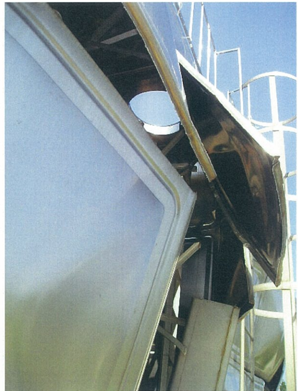
写真 5.3 剣地配水池の被害状況 (3)
