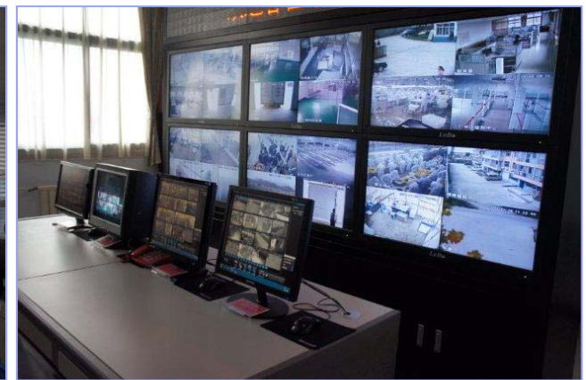
冷凍食品工場の監視カメラ集中管理室
