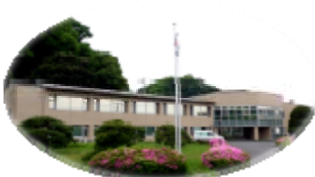
検査センター正面
