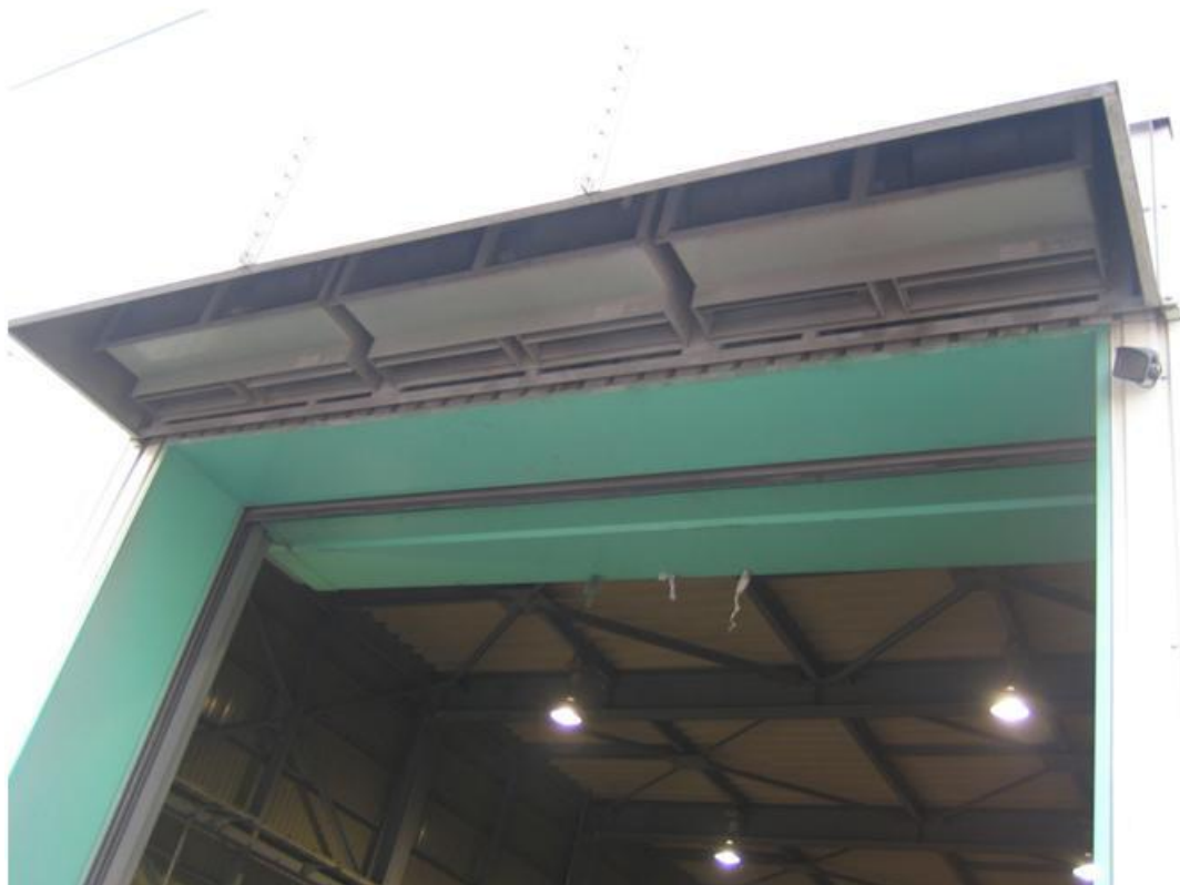
プラットホーム出入り口の送風機（エアーカーテンにて粉じんの大気中への拡散を防止）
