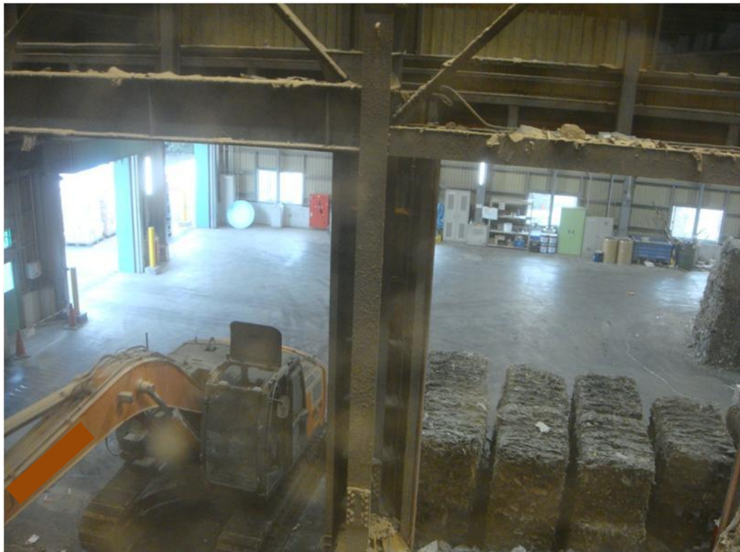
プラットホーム（廃棄物の受け入れ場所）全体図（上から撮影） 写真左奥の出入り口からトラックで搬入
