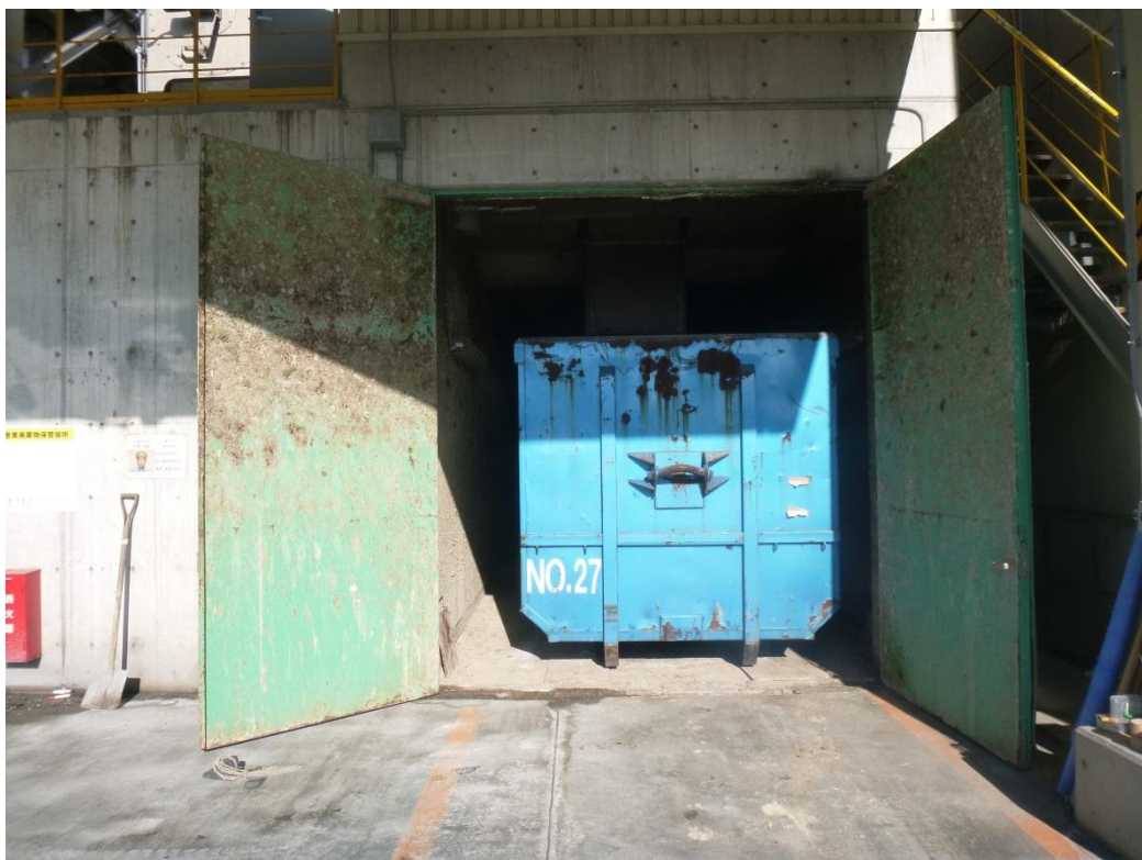
ヤード内（容器等で焼却灰を受け入れる）
