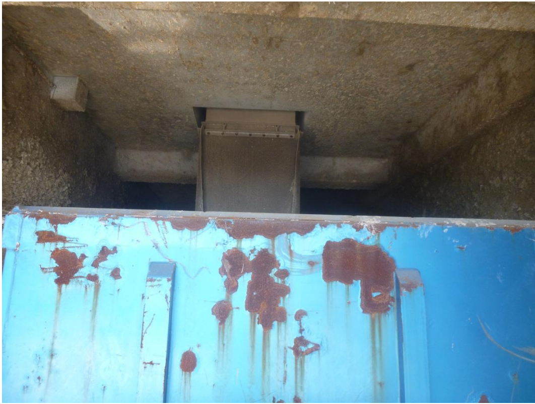
ヤード内の焼却灰などの排出口（ヤードの天井部）
