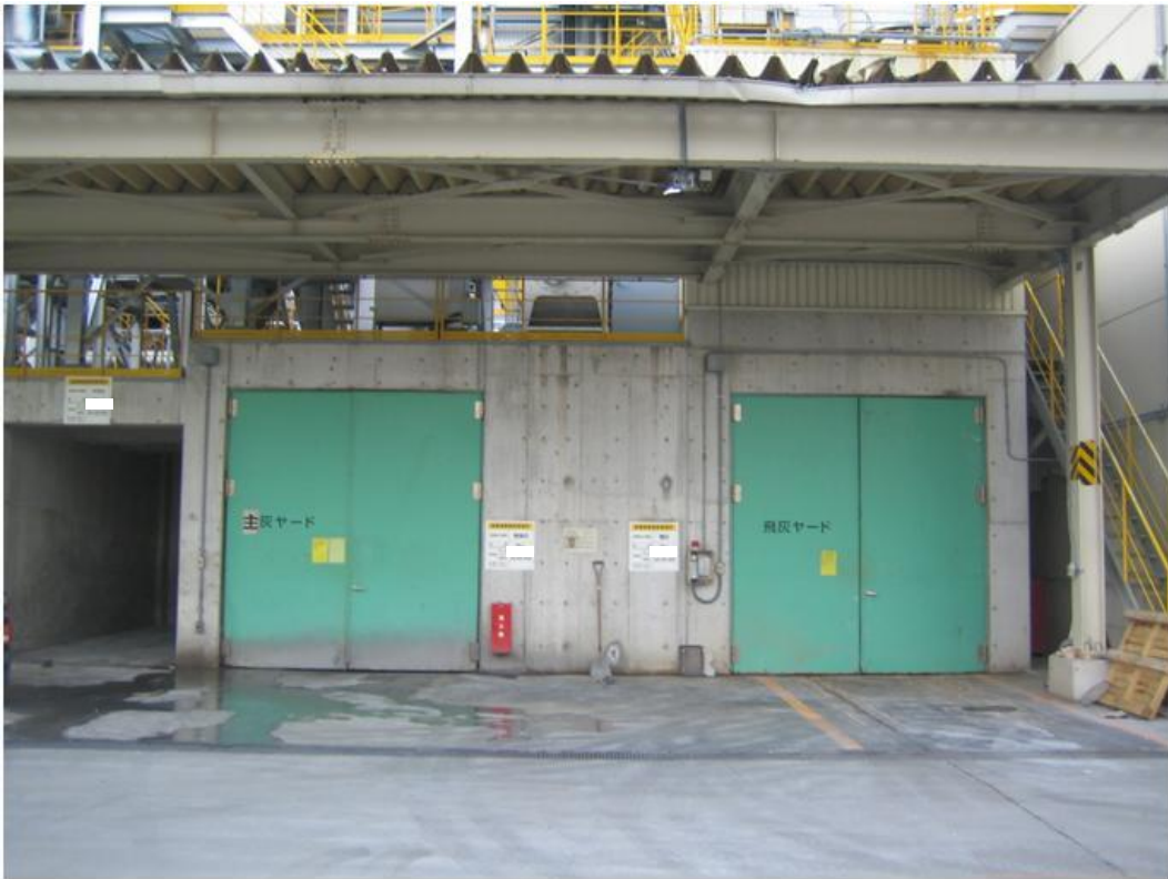
主灰及び飛灰ヤード（扉は、閉）
