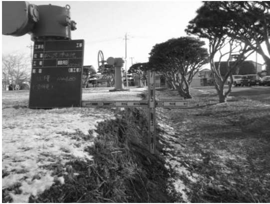
写真-1 蛇田浄水場配水池
