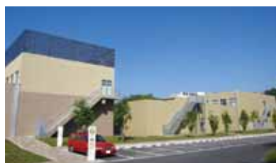
TMC 棟・ クラスター研究棟
