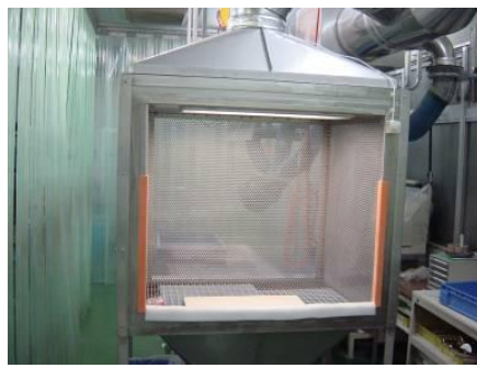
囲い式フード設置 (成形体加工作業)
