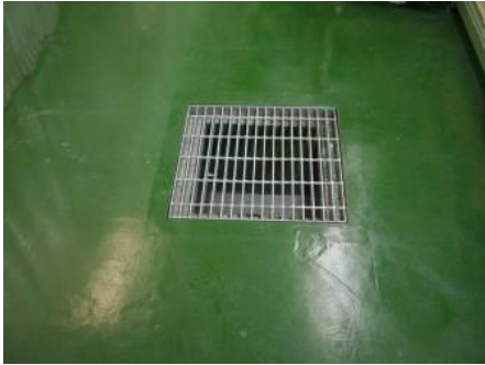
床面防塵塗装と 床ピットの設置 (水洗い清掃も可能とした)
