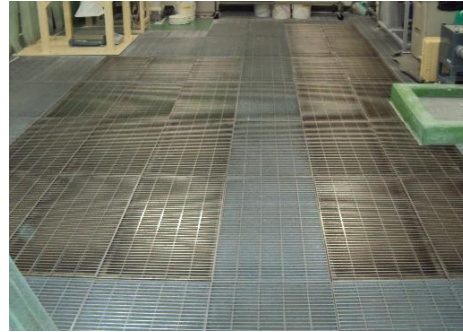
グレーチング化と水張り (粉末舞い上がり防止)
