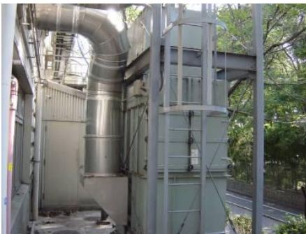
新規集塵機を導入 処理風量UP
