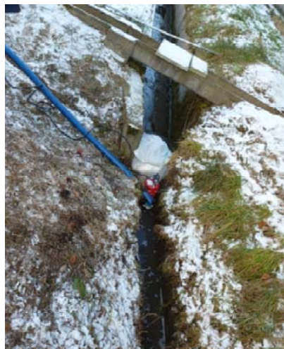
側溝に堰を設けて洗浄水を回収
