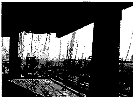
4 側面の換気状況
