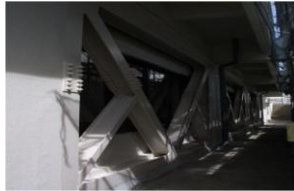
登戸地区研究本館耐震改修工事
