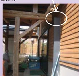
基礎部の沈下等による建物のひずみや接合部の分離が生じており、営業再開による2次被害(段差による転倒等)を防止するため基礎部の補強及び離脱防止金具等の設置を図る。
