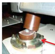
絶縁支柱が全損、設備の傾斜
