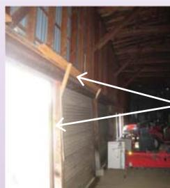
集出荷施設(木造つくり)全体に歪みが生じてシャッターの開閉も困難となっており、柱の補強対策を施し、倒壊防止を図る。
