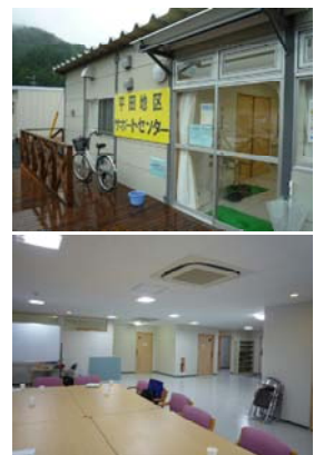
写真（上）サポートセンター外観、（下）集会室
