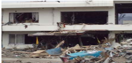
○津波により浸水した公民館 (岩手県)
