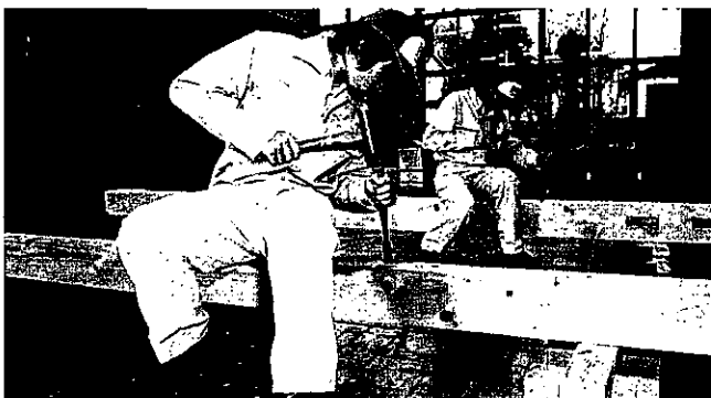
木造の実大部材について、墨付け・手加工の作業に取り組む様子。
