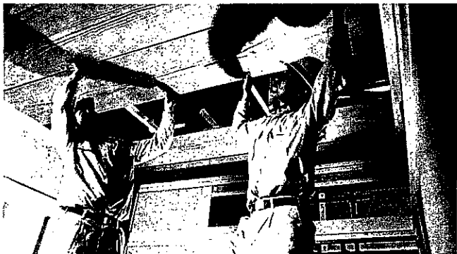
和室の天井仕上げとして、敷き目板張り天井板の取付けを行っている様子。
