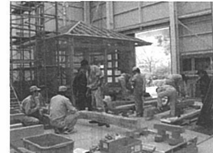
木造住宅の施工
