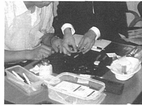
ケーブルの施工2
