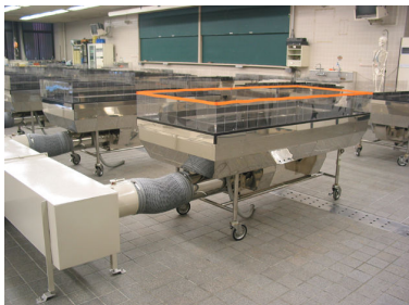
局所排気装置の各実習台への設置
