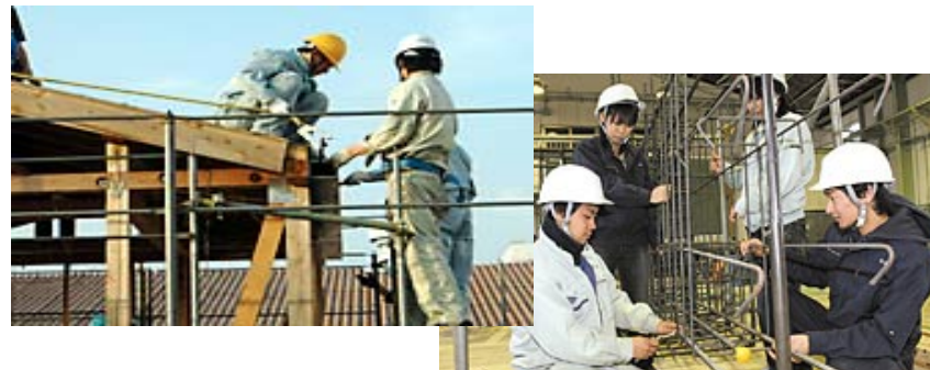
建築施工実習
