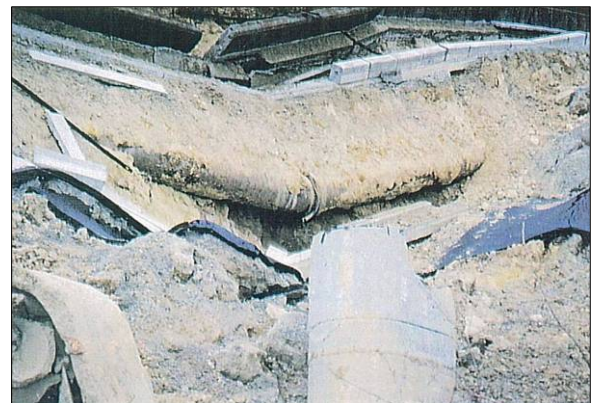
b) φ450 鋳鉄管 継手部抜け
