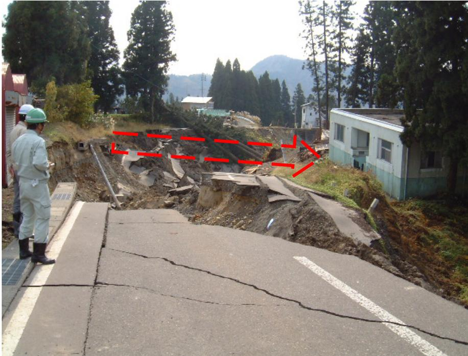
新潟県中越地震(H16.10.23)による地滑りで数10m移動した浄水場(小千谷市塩殿簡易水道)
