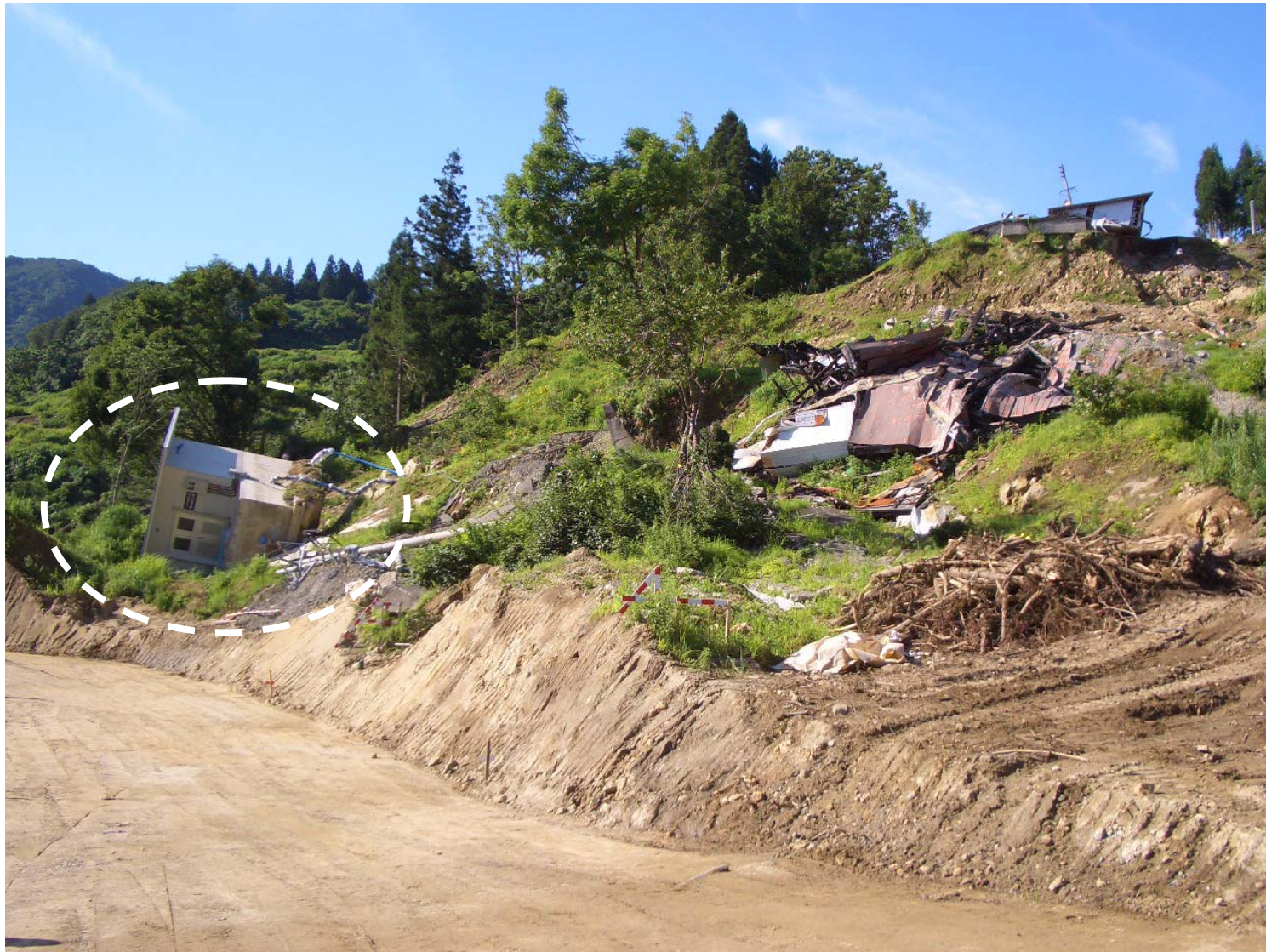
斜面崩壊により滑落した中継ポンプ場（山古志地域）
