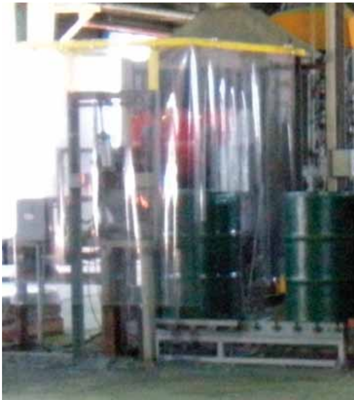
図 3-2b : 入口のビニールカーテン
