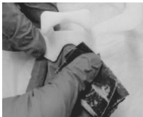
図 2. 紙やすりを用いて粘着物を除去する
