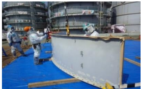
タンク片揚重作業状況
