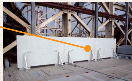
東作業床衝立遮へい状況
