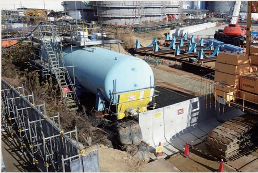
汚染水タンク解体時のL型コンクリート擁壁及び鉛板遮へい衝立による遮へい状況写真 資料提供:大成建設(株)
