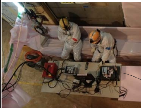
低線量エリアでロボットを遠隔操作
