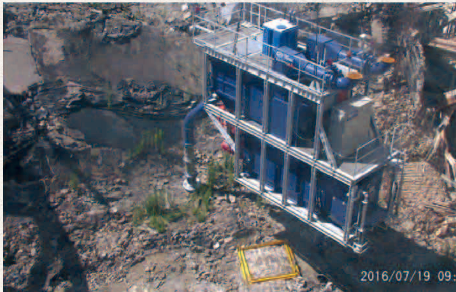
1F-1号機 原子炉建屋5階 大型ガレキ吸引機によるルーフブロック等の吸引作業状況 資料提供:清水建設(株)
