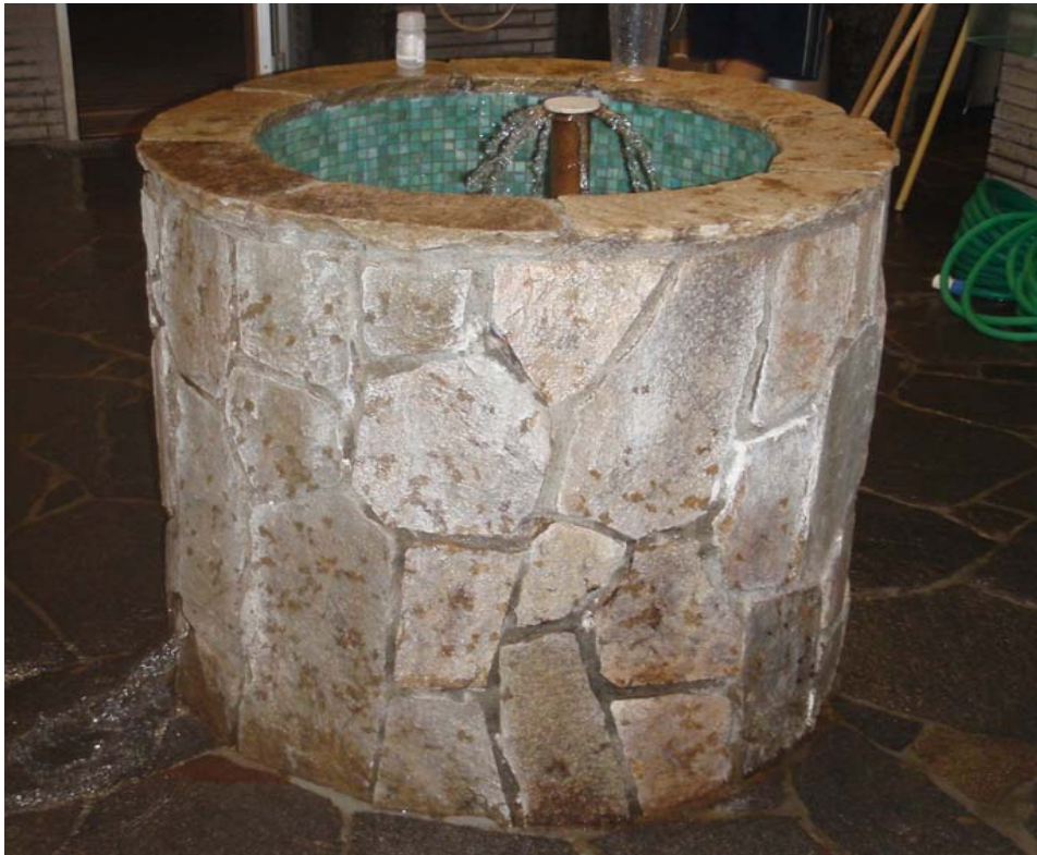
かけ湯浴槽の水位検知管
