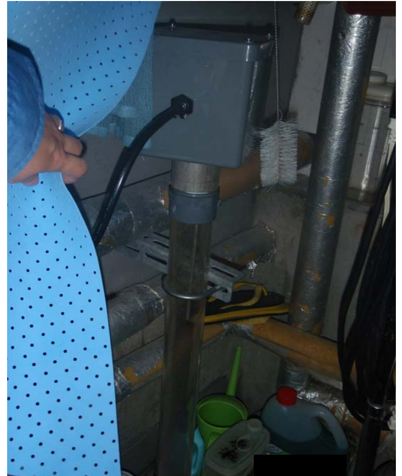
かけ湯浴槽の水位検知管
