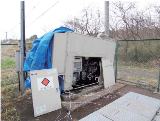
内部ラジエーター等が破損して、使用不可となった井戸の自家発電機
