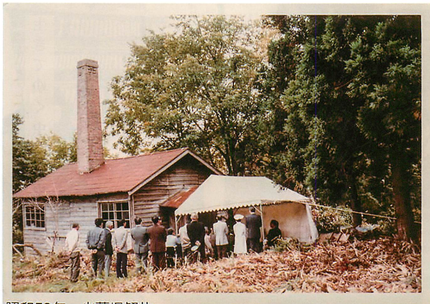
昭和58年 火葬場解体
