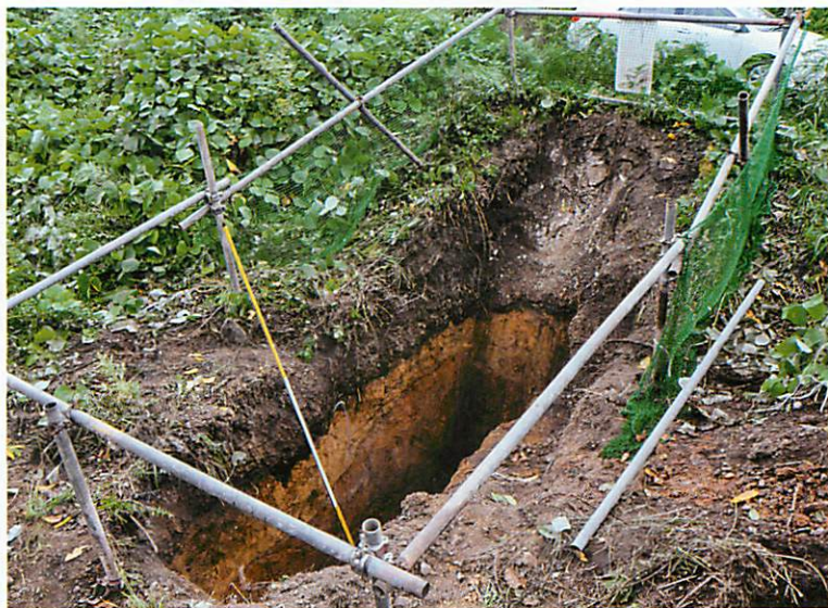
(写真2) ミニバックによる試掘坑の設置状況
