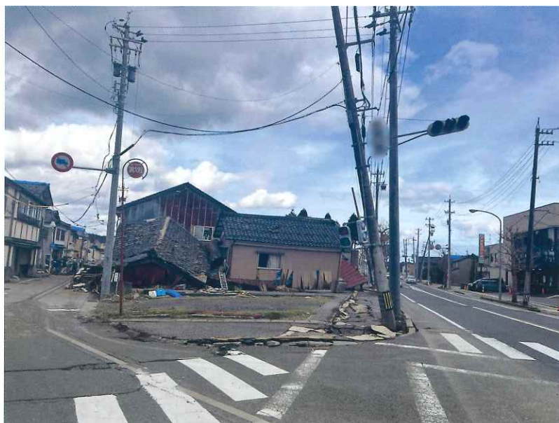
被災した住宅地、このような光景が延々と続いていました
