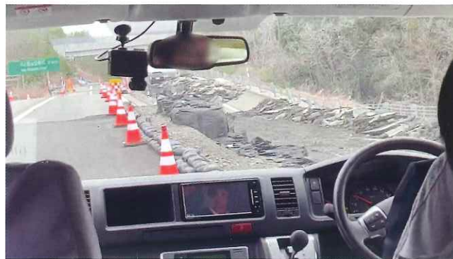
土砂崩れによる道路の崩落、 何とか片側の車線が通れる状況
