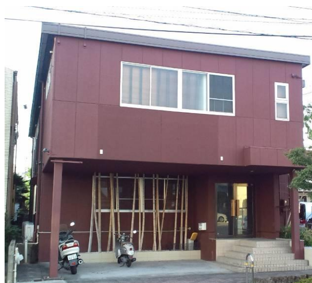
2階部分がショートステイのスペース
