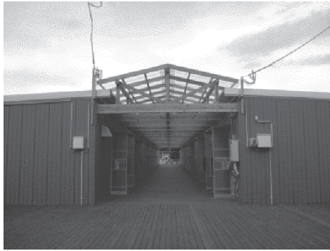
(左) ケアゾーンの仮設住宅（正面）
