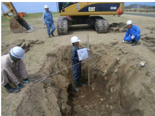
反応箇所の掘削
